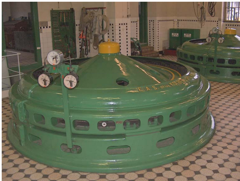
Obr.4: Generátor na jedné ose s Francisovou turbínou, 125 otáček za minutu
