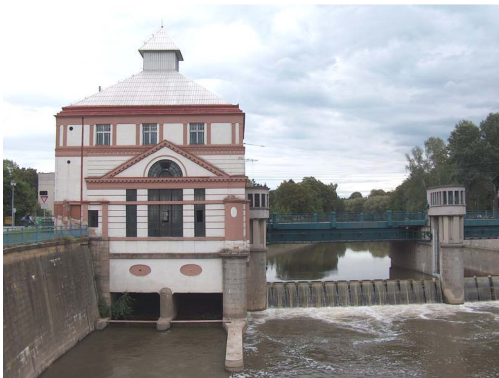
Obr. 10: Elektrárna na Orlici
