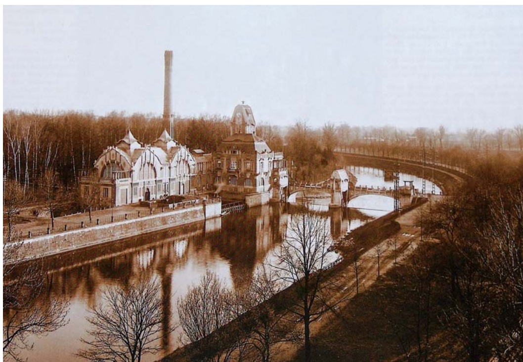
Obr. 3: První městská elektrárna
