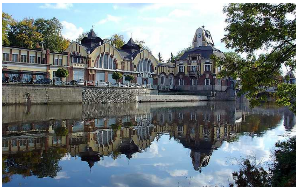
Obr.5: Elektrárna na Labi
