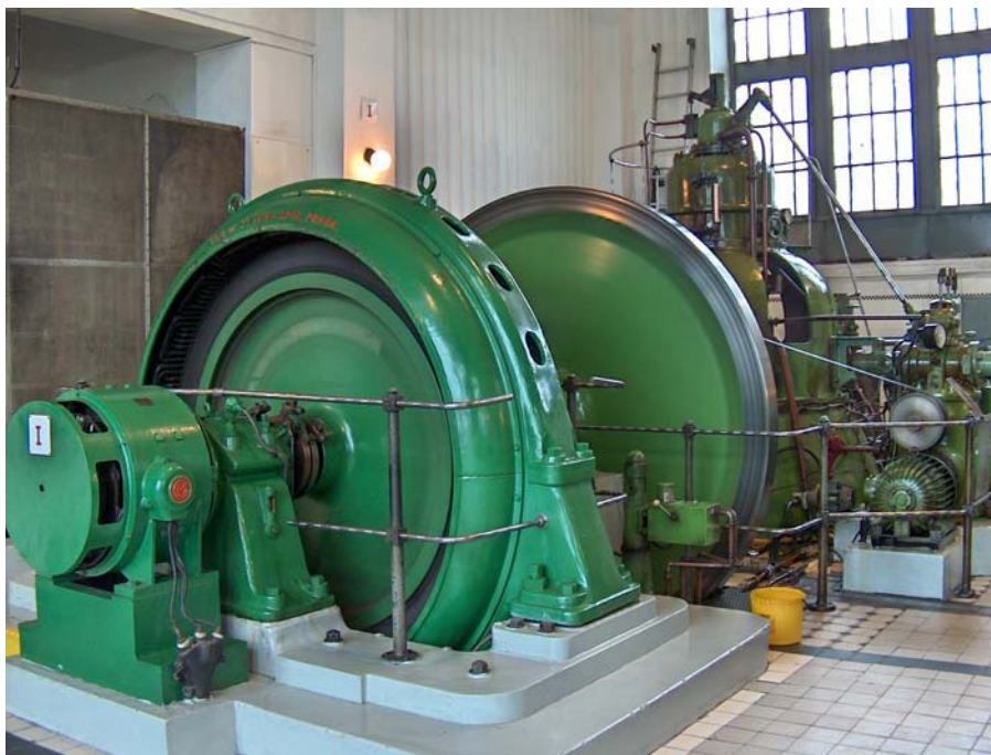
Obr. 11: Soustrojí v Elektrárně na Orlici
