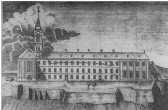
Obr. 8: Úder blesku do budovy kláštora (Ilustrácia z diela L. Schaffratha)
