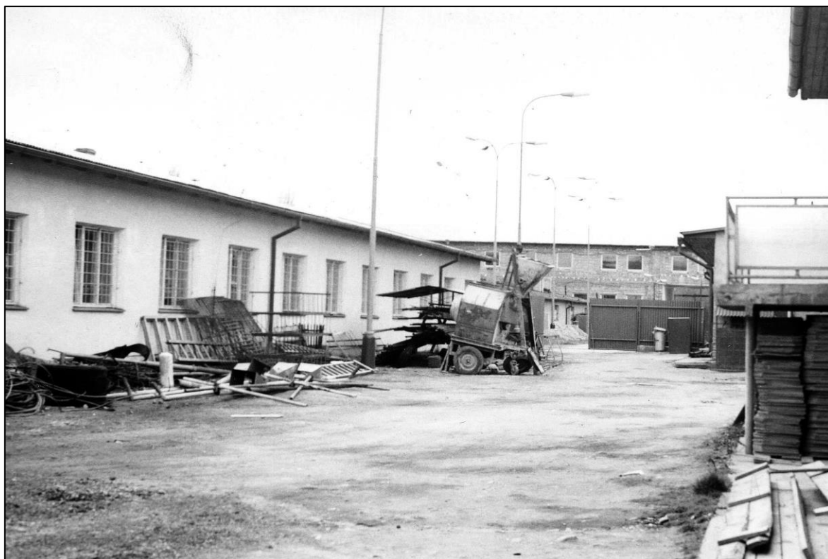
Z výstavby objektu NVÚ Nové Sedlo (foto: KDH)
